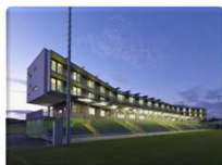
Akademiegebäude, Tribüne, Platz 2
